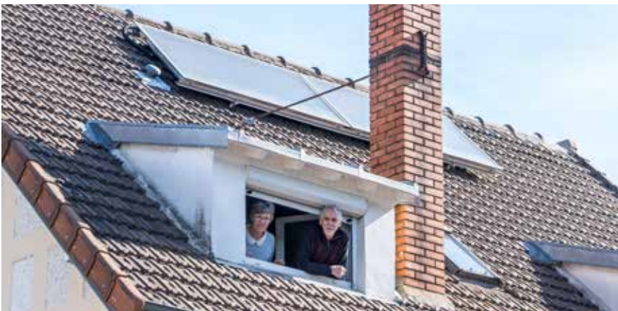
Installer des panneaux solaires sur le toit de son domicile est rentable après dix voire quinze ans.
