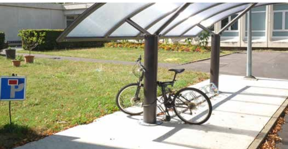
Installation d'un rack à vélos en plus d'un abri pour vélos dans l'enceinte de l'école maternelle Val-de-Bièvre.
