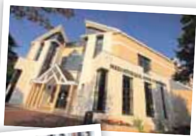
Médiathèque Anne Fontaine, rafraîchissement de la façade.
