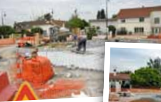
Reconstruction de la voirie.
