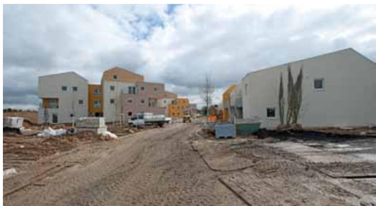
Le secteur Bas-Graviers/Crocheteurs renaît avec la construction en cours de 123 logements sociaux... et la réalisation du parc paysager bordant les habitations.
