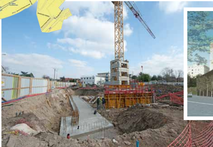
Les fondations du futur complexe sont en cours de réalisation. Avant le montage de la structure du bâtiment...
