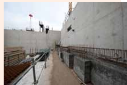
Construction du cinéma en centre-ville.
