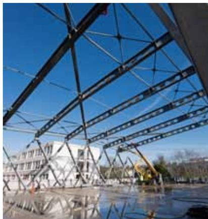
d'environ 500 tonnes. La poutre la plus longue mesure 31 mètres et pèse 9,3 tonnes. Les morceaux de poteaux sont assemblés entre eux par des boulons, qui seront ensuite cachés, donnant l'illusion que l'ensemble d'une façade ne représente qu'une seule pièce. Étonnant ! ○
