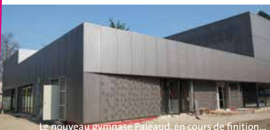
Le nouveau gymnase Pajeaud, en cours de finition...
