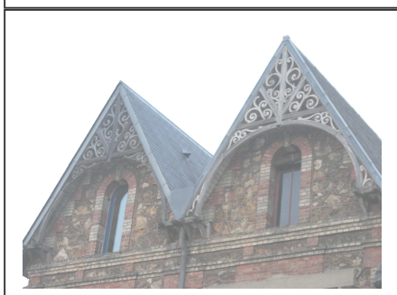
Détail de la toiture
