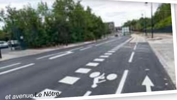
Réfection de la voirie, allée Martin Luther King,
