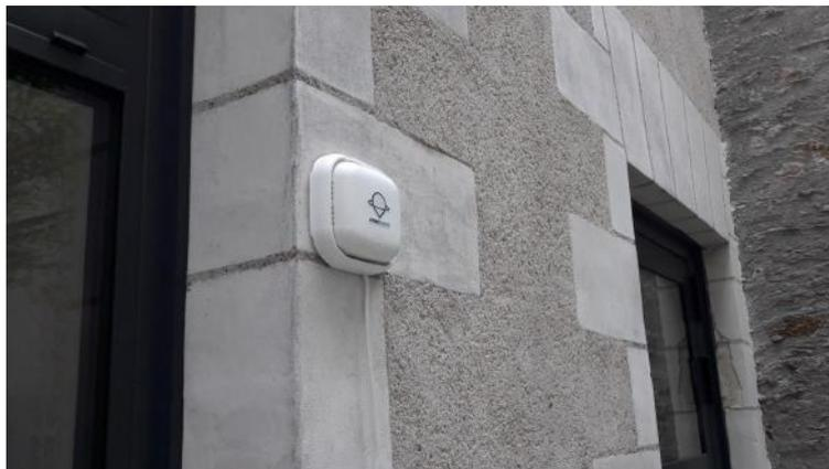
Figure 3 : Capteur Atmotrack installé en extérieur
