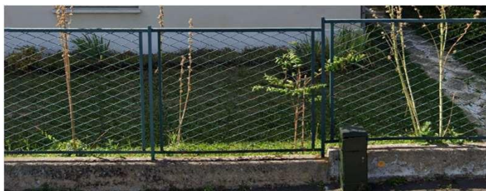
Modèle original de grille, avec une structure tubulaire similaire aux gardes corps, majoritairement à claire-voie avec un fin grillage
