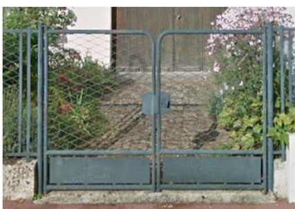
Modèles originaux de portail et de portillon, avec une structure tubulaire similaire aux gardes corps, et majoritairement à claire-voie avec un fin grillage
