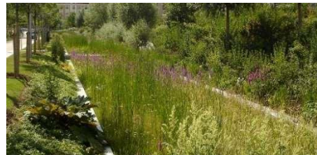
Noue végétalisée (hors territoire)
