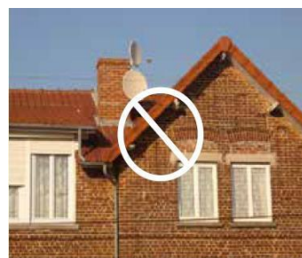
Baies réduites pour recevoir des menuiseries standard
