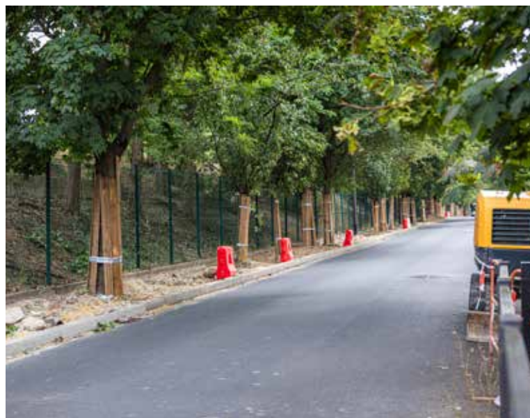
➤ Travaux sur la rue Joseph Delon
