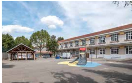
École Ferdinand-Buisson rénovée, août 2019.
